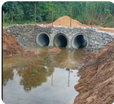
Manilhas instaladas para drenagem
