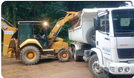
Retroescavadeira carregando caminhão em serviço de estrada
